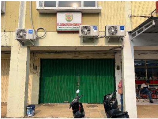
Gambar C.4 5 Tampak Depan Gedung Perusahaan
